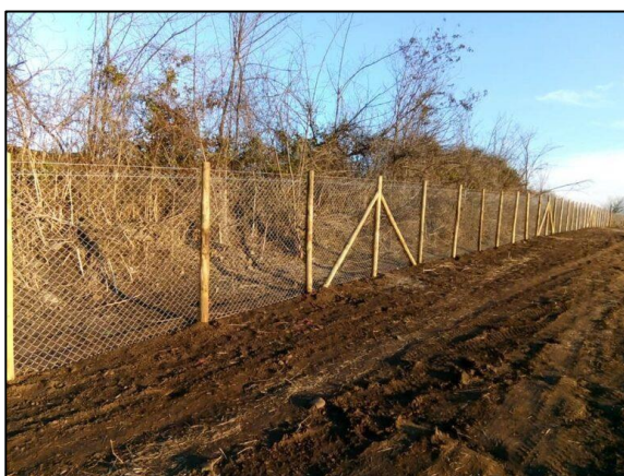
Imagen 2: Imagen referencial refuerzo 30 metros
