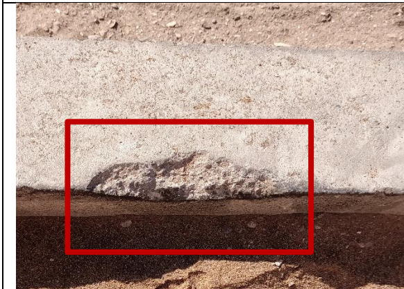
Fotografía N° 23 de 5-05-2023: solera tipo A pérdida de aristas, tramo 4 calle Patricio Lynch entre Orella y Riquelme altura 1363, acera poniente.
