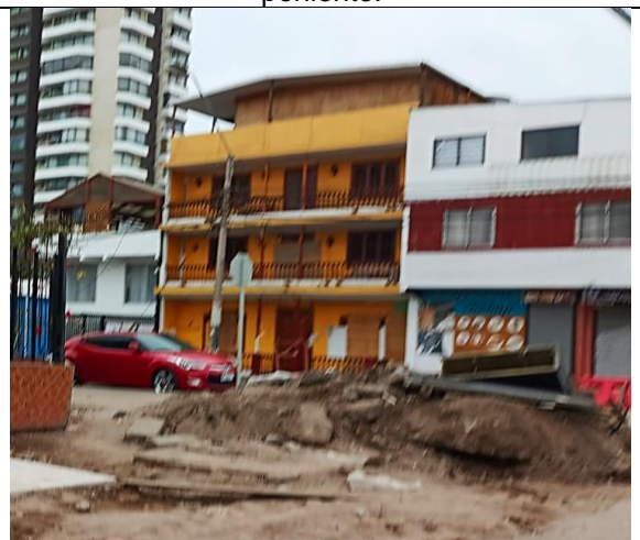
Fotografía N° 6 de 22-05-2023: se observan escombros en tramo 2, calle J.J. Pérez con Vivar sur.
