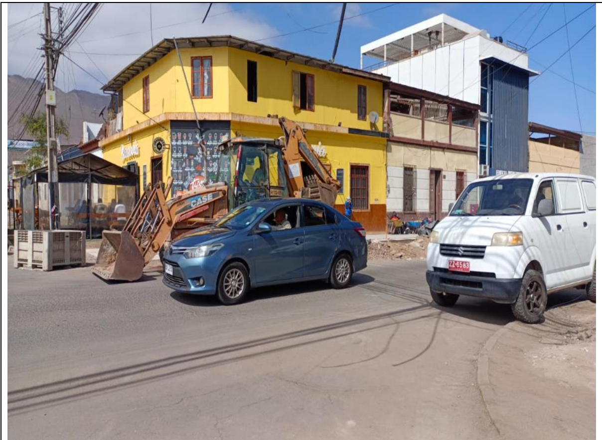
Fotografía N° 3 de 18-05-2023: maquinaria sin señal de tránsito PT-4, tampoco la señal de angostamiento a la derecha PTF-1b, calle Vivar con Riquelme.
