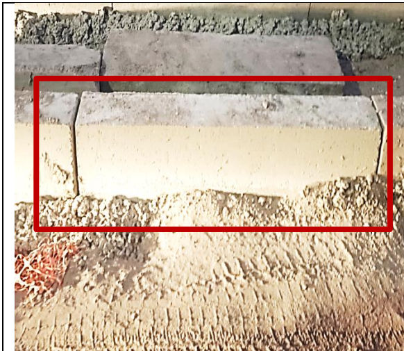
Fotografía N° 1 de 22-05-2023: Soleras tipo A, sin emboquillado, tramo 1, calle Eleuterio Ramirez entre Bulnes y Orella, situación que se repite en la cuadra completa, acera oriente.
