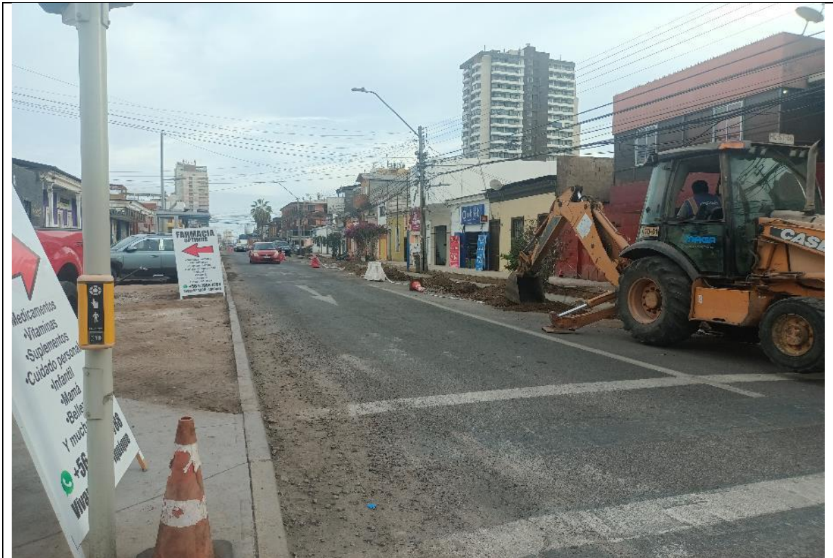
Fotografía N° 1 de 5-05-2023: maquinaria sin señal de tránsito PT-4, tampoco la señal de angostamiento a la derecha PTF-1b, calle Vivar entre Orella y Riquelme.
