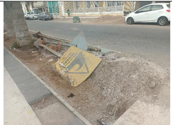
Fotografía N° 12 de 8-05-2023: se observan escombros en las jardineras, tramo 4, calle Patricio Lynch, altura 1277 acera poniente.
