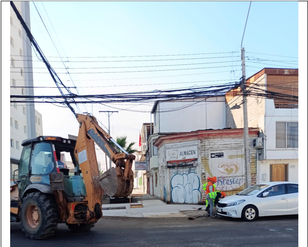
Fotografía N° 1 de 08-05-2023: se observa el uso de maquinaria en calzada para trabajos de excavaciones en la esquina de calle Patricio Lynch con Orella, acera oriente.
