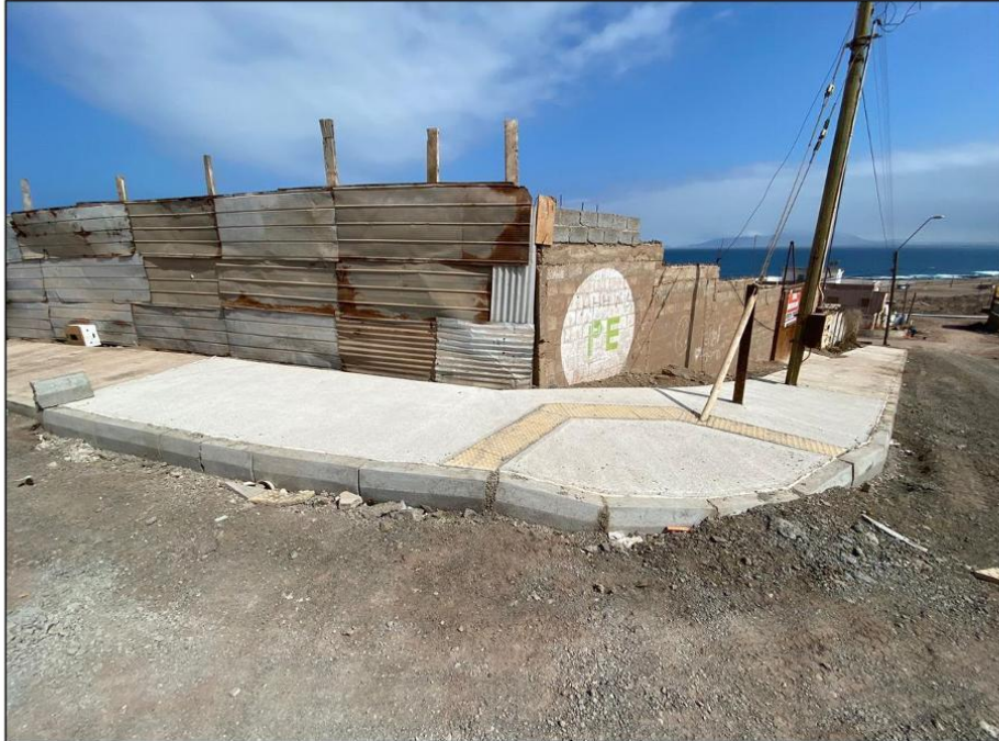
Esquina entre Pasaje 5 y Custodio Leiva
