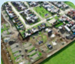
VISITA DE OBRAS COMITÉ EL ENCUENTRO, LA JUNTA
