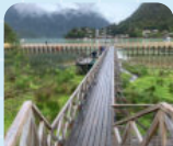
PASARELAS CALETA TORTEL
