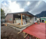
AVANCE DE OBRAS CENTRO COMUNITARIO AYSÉN
