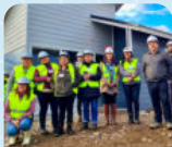
VISITA AVANCE DE OBRAS, PROYECTO VICARIATO AYSÉN
