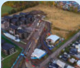
VISITA AVANCE DE OBRAS 70% LOMAS II, COYHAIGUE
