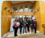
94% DE AVANCE CENTRO COMUNITARIO DE CUIDADOS
