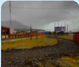
CONSTRUCCIÓN BORDE URBANO VILLA O'HIGGINS
