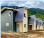
AVANCE DE OBRAS COMITÉ PATAGONIA ALEGRE, PUERTO CHACABUCO
