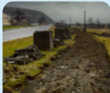
CONSTRUCCIÓN BORDE URBANO VILLA O'HIGGINS
