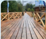
PASARELAS CALETA TORTEL
