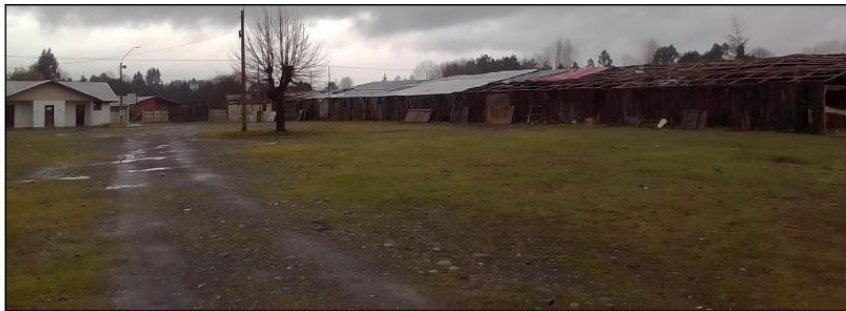
Vista general – sector acceso principal
