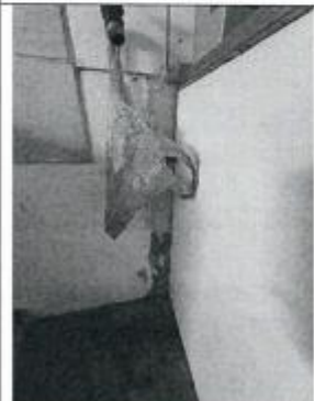
Falta de pintura en muros
