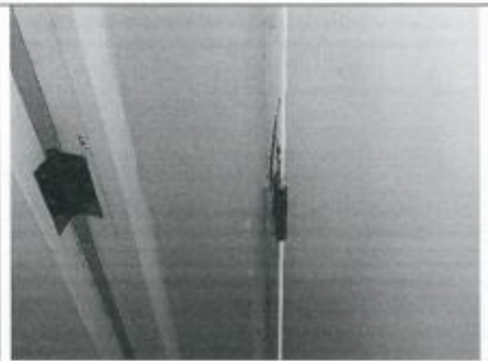
Realizaron cambio de bisagras reutilizadas, por nuevas.
