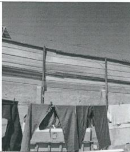
Situación anterior a realizar trabajos en muro medianero.
