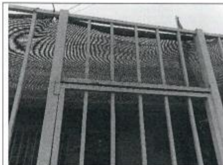
En ítem reparación Rejas no se aprecia tratamiento ni colocación de anticorrosivo.
