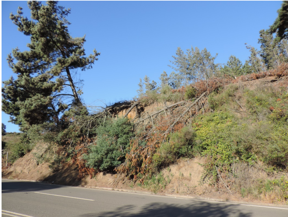
FIGURA N° 7—3 Deslizamiento de suelo en la comuna de Pelluhue, donde se evidencia los árboles caídos
