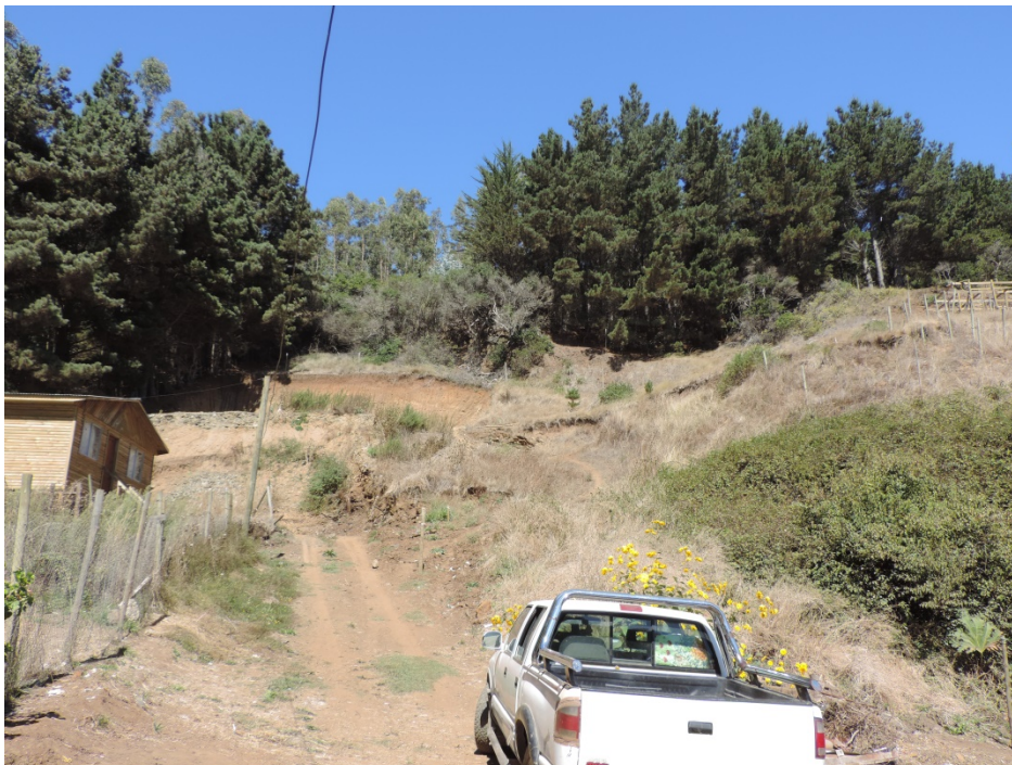
FIGURA N° 7—4 Escarpe asociado a deslizamiento en la comuna de Pelluhue
