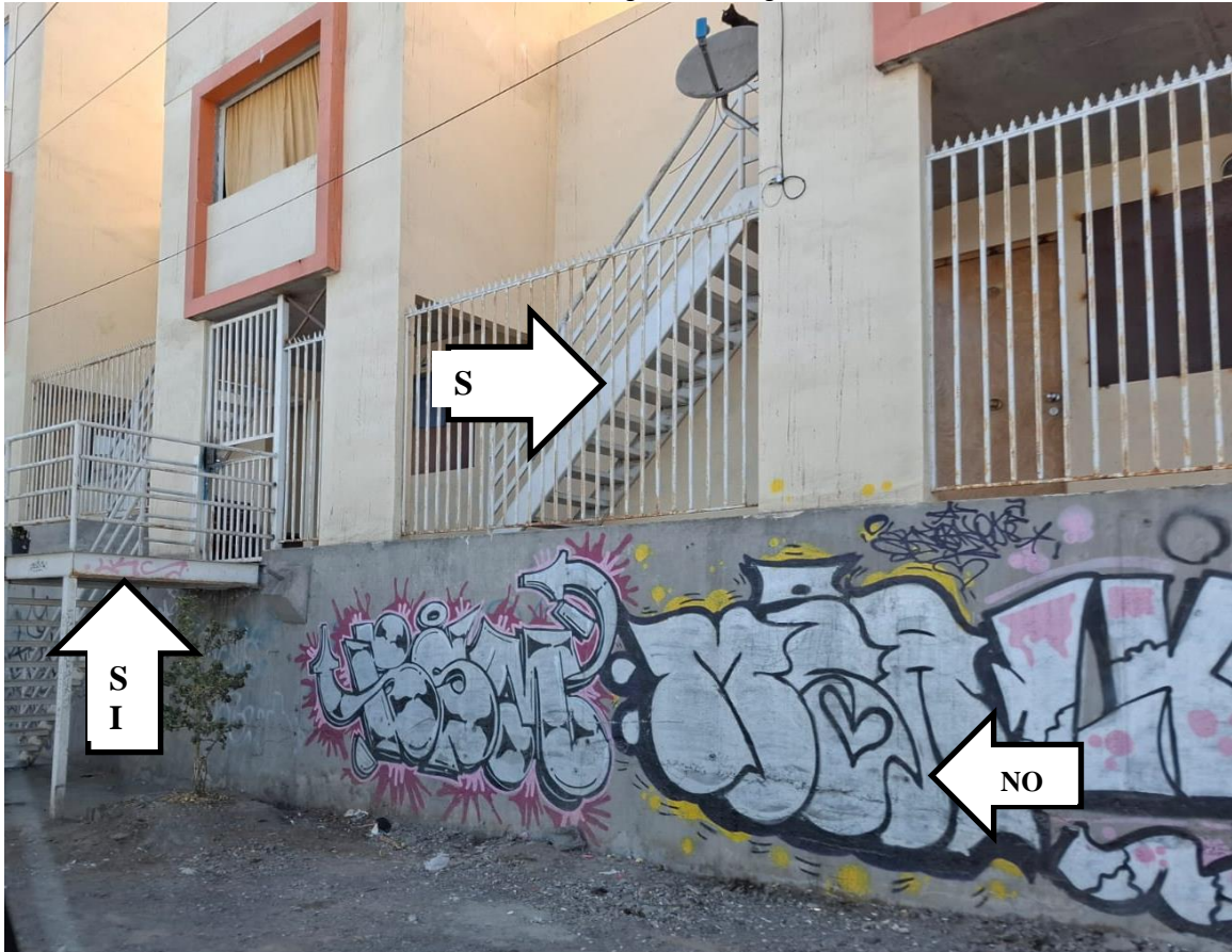
Figura N°6 Demolición Vivienda, retiro de rejas y escaleras metálicas perimetrales de todo el conjunto habitacional, no se demuelen muros de contención
