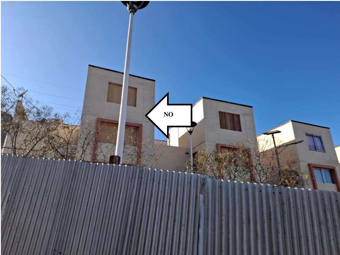
Figura N°11 Demolición Vivienda, se mantienen luminarias
