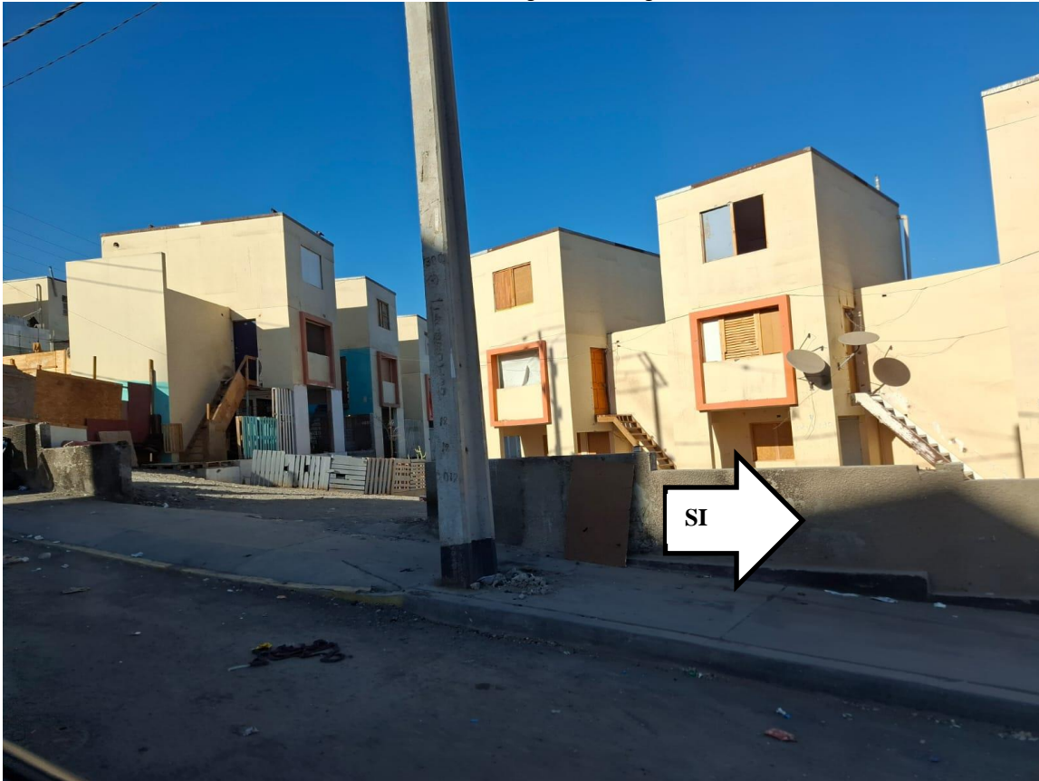
Figura N°10 Demolición Vivienda, cierres perimetrales
