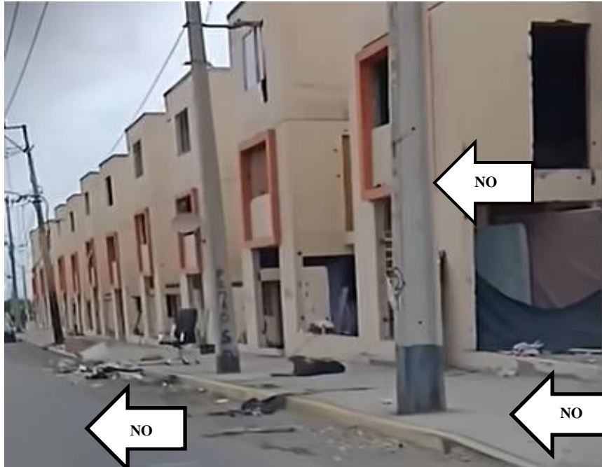
Figura N°4 Demolición Vivienda, no se demuele calzada asfáltica, aceras peatonales no se sacan postación eléctrica pública
