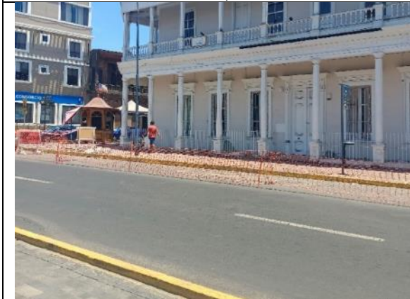
Fotografía N° 3 de 20-02-2023: cierre provisorio, tramo 9 calle Aníbal Pinto entre Serrano y Tarapacá, acera poniente (peatones transitando por área de trabajos).
