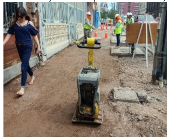
Fotografía N° 6 de 31-01-2023: cierre provisorio, tramo 10 calle Aníbal Pinto entre Gorostiaga y Wilson, acera poniente, (peatones transitando mientras se ejecutan trabajos de compactación de base).
