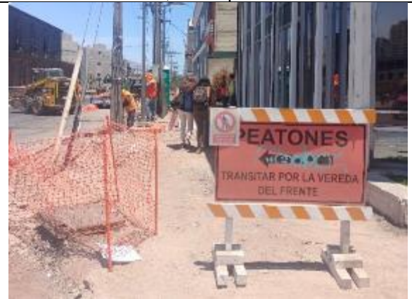
Fotografía N° 4 de 20-02-2023: cierre provisorio, tramo 9 calle Aníbal Pinto entre Tarapacá y Thomson, acera poniente (peatones transitando mientras se ejecutan trabajos de excavaciones).
