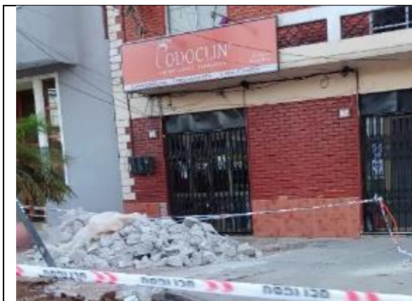
Fotografía N° 1 de 03-02-2023: se observan escombros en la acera durante la jornada de la mañana, tramo 8 calle Patricio Lynch entre Almirante Latorre y Gorostiaga, acera oriente.
