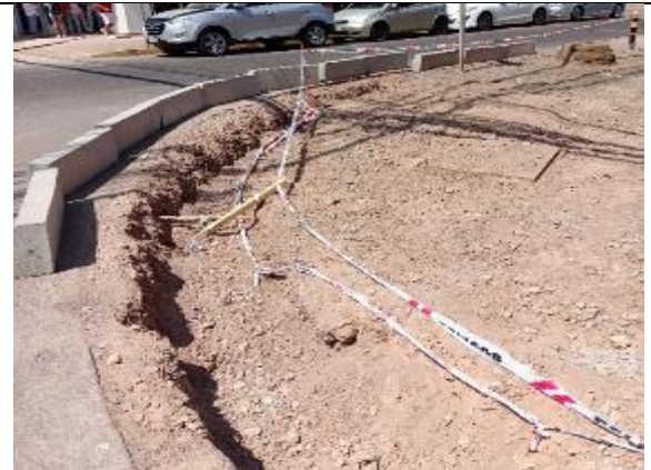
Fotografía N° 2 de 07-02-2023: cierre provisorio, tramo 9 calle Aníbal Pinto entre Bolívar y San Martín, acera poniente.
