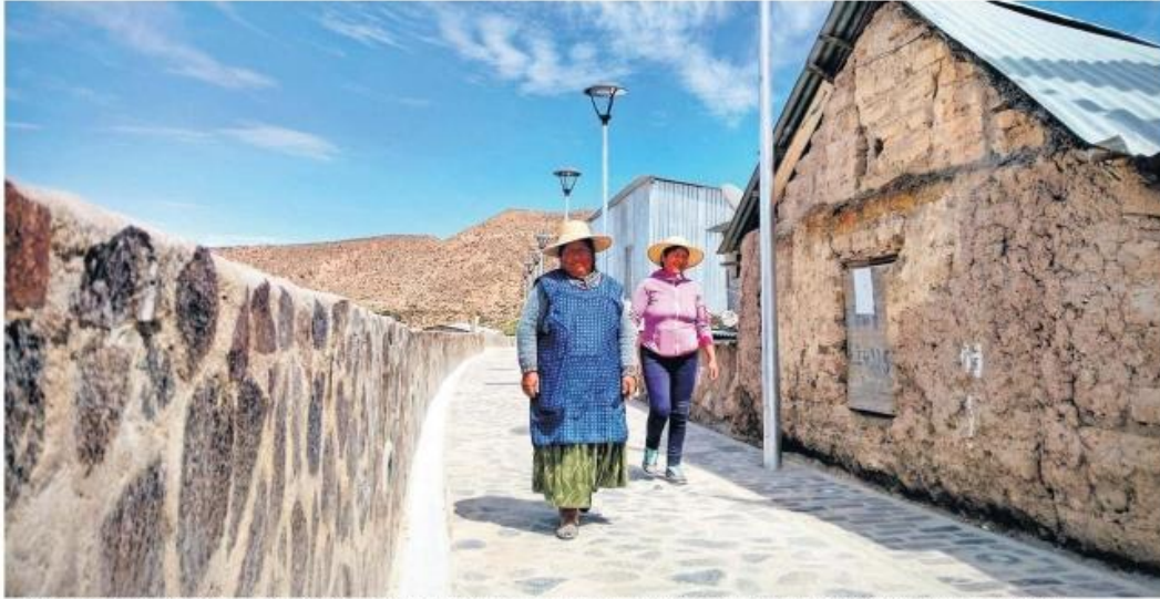
LA OBRA CONSOLIDA UN SECTOR COMPLEJO EN SU MORFOLOGÍA, CON MEJORES ACCESOS, PAVIMENTACIÓN CON PERTINENCIA LOCAL, MUROS DE CONTENCIÓN CON PASAMANOS, ENTRE OTROS.
