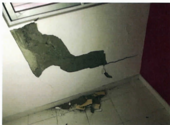
Figura N°1 Grietas diagonales en Antepechos
