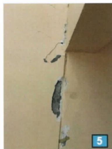
Figura N°8 y 9 (4 y 5) Fisura de hormigón de diversos espesores y longitudes que afectan el monolitismo del elemento y pérdida de mortero de pega en la cantería de la albañilería, manifestada como fisura y que no presenta rotura de unidades.
