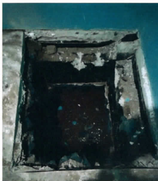
Figura N°5 Descenso del suelo en sello de fundación y las socavaciones en la calicata y el gran grado de humedad del suelo
