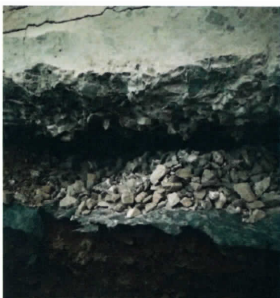
Figura N°5 Descenso del suelo en sello de fundación y las socavaciones en la calicata y el gran grado de humedad del suelo
