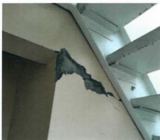
Figura N°2 Grietas en eje 2 en paños de albañilería en pisos 1 y piso 2
