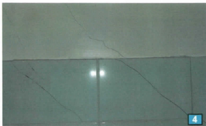
Figura N°8 y 9 (4 y 5) Fisura de hormigón de diversos espesores y longitudes que afectan el monolitismo del elemento y pérdida de mortero de pega en la cantería de la albañilería, manifestada como fisura y que no presenta rotura de unidades.
