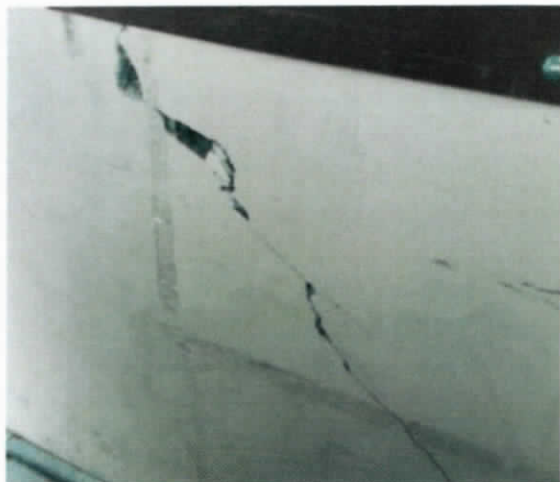
Figura N°1 Grietas diagonales en Antepechos
