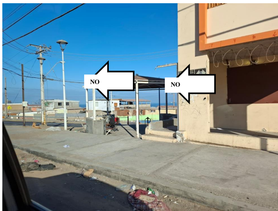
Figura N°13 Demolición Vivienda, se mantienen área de juegos, estructura sombreadero y luminarias
