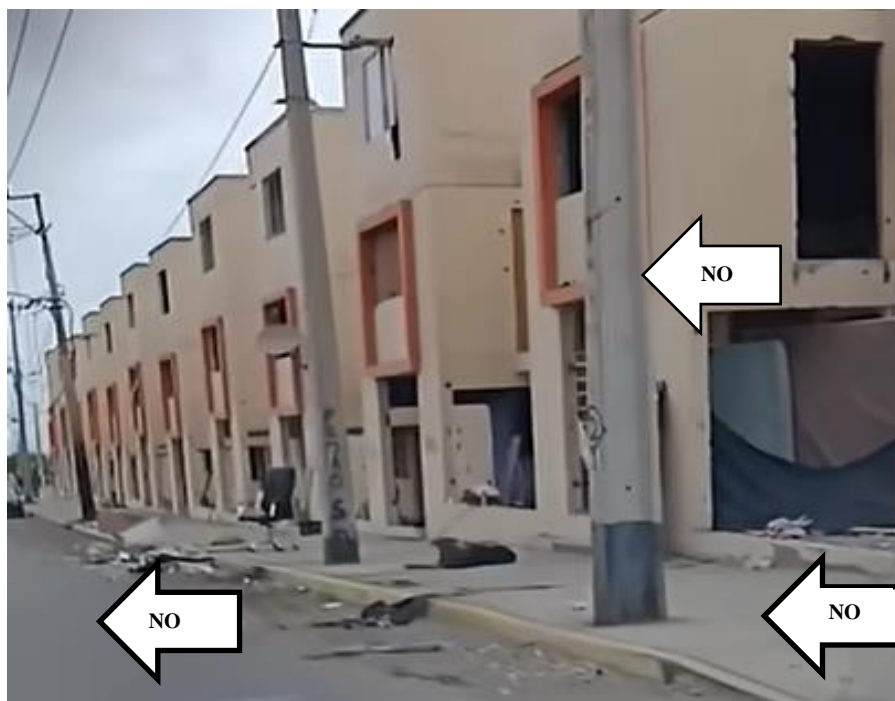
Figura N°5 Demolición Vivienda, no se demuele calzada asfáltica, aceras peatonales no se sacan postación eléctrica pública
