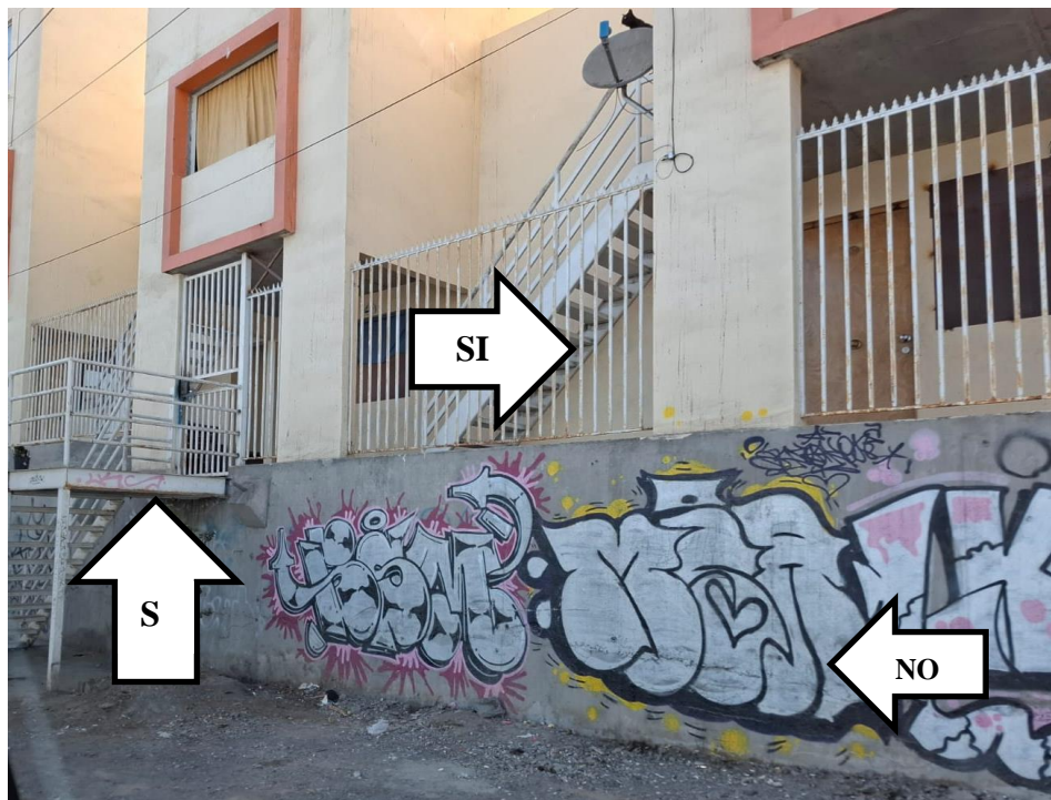
Figura N°7 Demolición Vivienda, retiro de rejas y escaleras metálicas perimetrales de todo el conjunto habitacional, no se demuelen muros de contención
