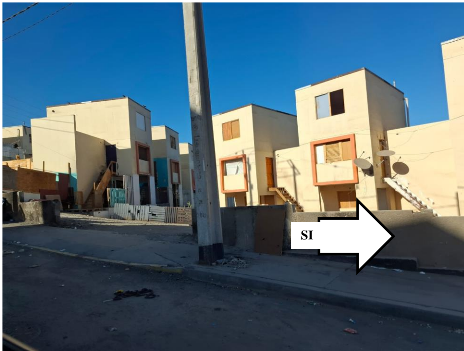
Figura N°11 Demolición Vivienda, cierres perimetrales
