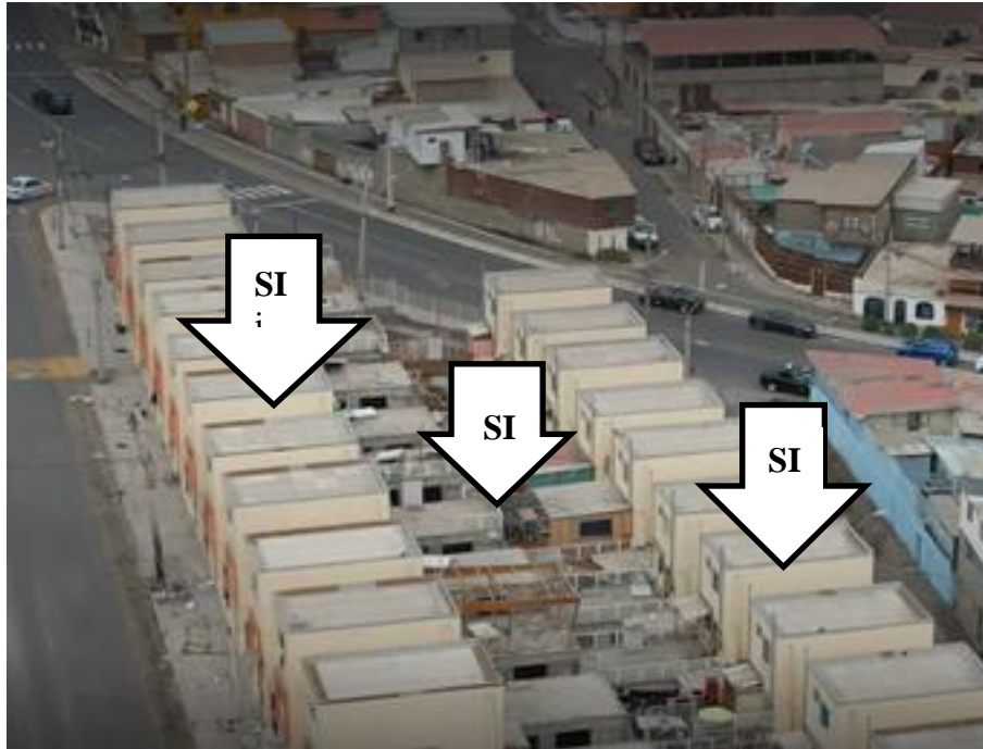
Figura N°6 Demolición Vivienda, ampliaciones en patios interiores
