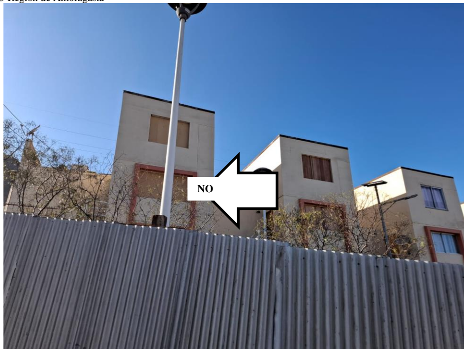
Figura N°12 Demolición Vivienda, se mantienen luminarias
