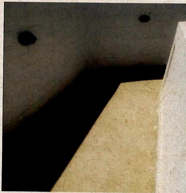
Foto N° 21: Rampa de acceso para discapacitados
