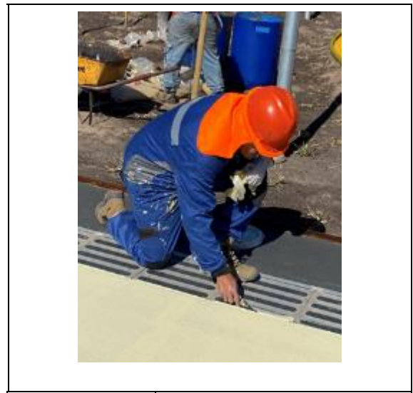
Imagen N°: 4 Fecha captura: 11 de agosto de 2025 Ubicación: Parque kaukari 3° Etapa 3A. Contenido: Trabajador sin guantes de cabritilla.
