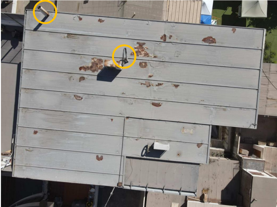
Fig. 04. Situación de ductos verticales en cubierta.
