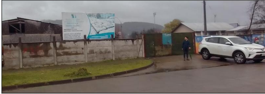
Acceso principal por Calle Los Carrera
