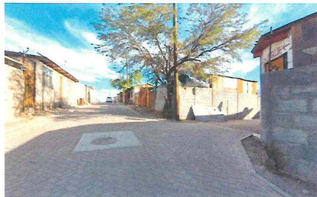
Fotos posteriores a la intervención
