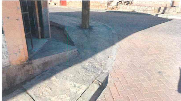
Alta pendiente en vereda y desniveles existentes no permiten generar encuentro calle-pasaje.
