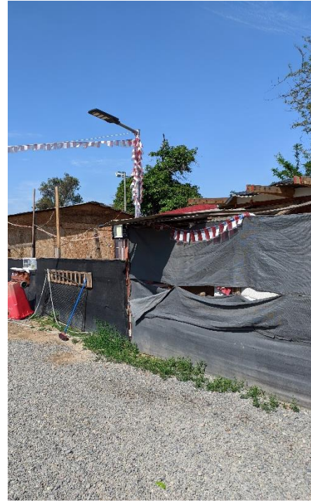
Fotografía N° 6 Asentamiento Precario Galvarino, comuna La Florida Contenido Iluminación peatonal fotovoltaica.
