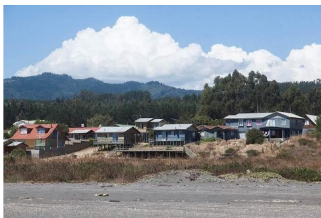
Fotografía 6. Viviendas construidas sobre dunas activas sector la Sirena, comuna de Pelluhue.
