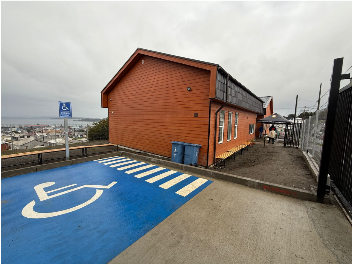
Centro Comunitario de Cuidados de Quellón.
