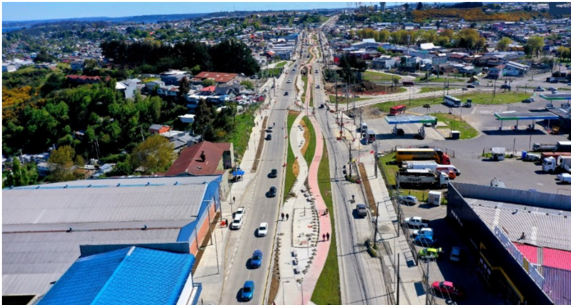
Proyecto de Mejoramiento Avenida Presidente Ibañez, Puerto Montt.
