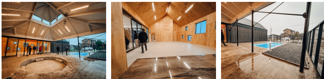
Centro Comunitario Barrio Caicumeo, Ancud.
