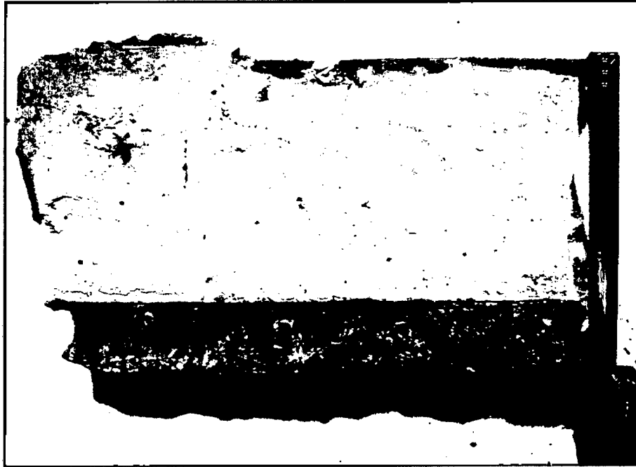
Fotografía 10: Resto del estuco retirado de la mampostería para abrir el piso
