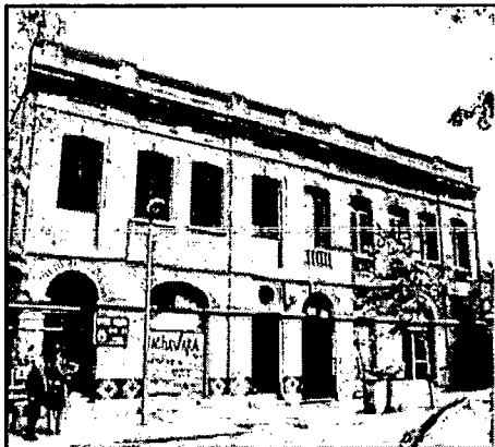
Fotografía de fachada
