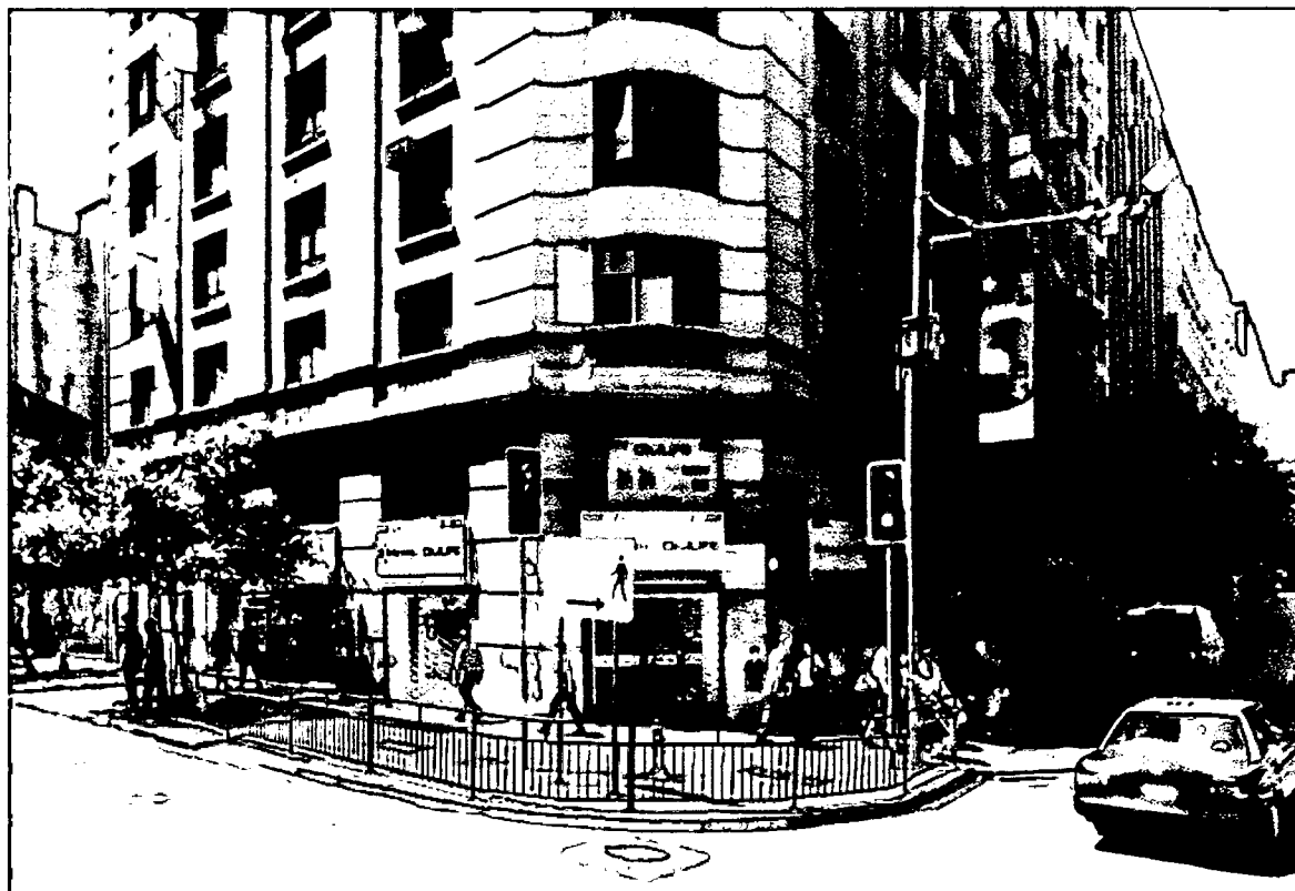
VISTA LOCAL EXISTENTE
