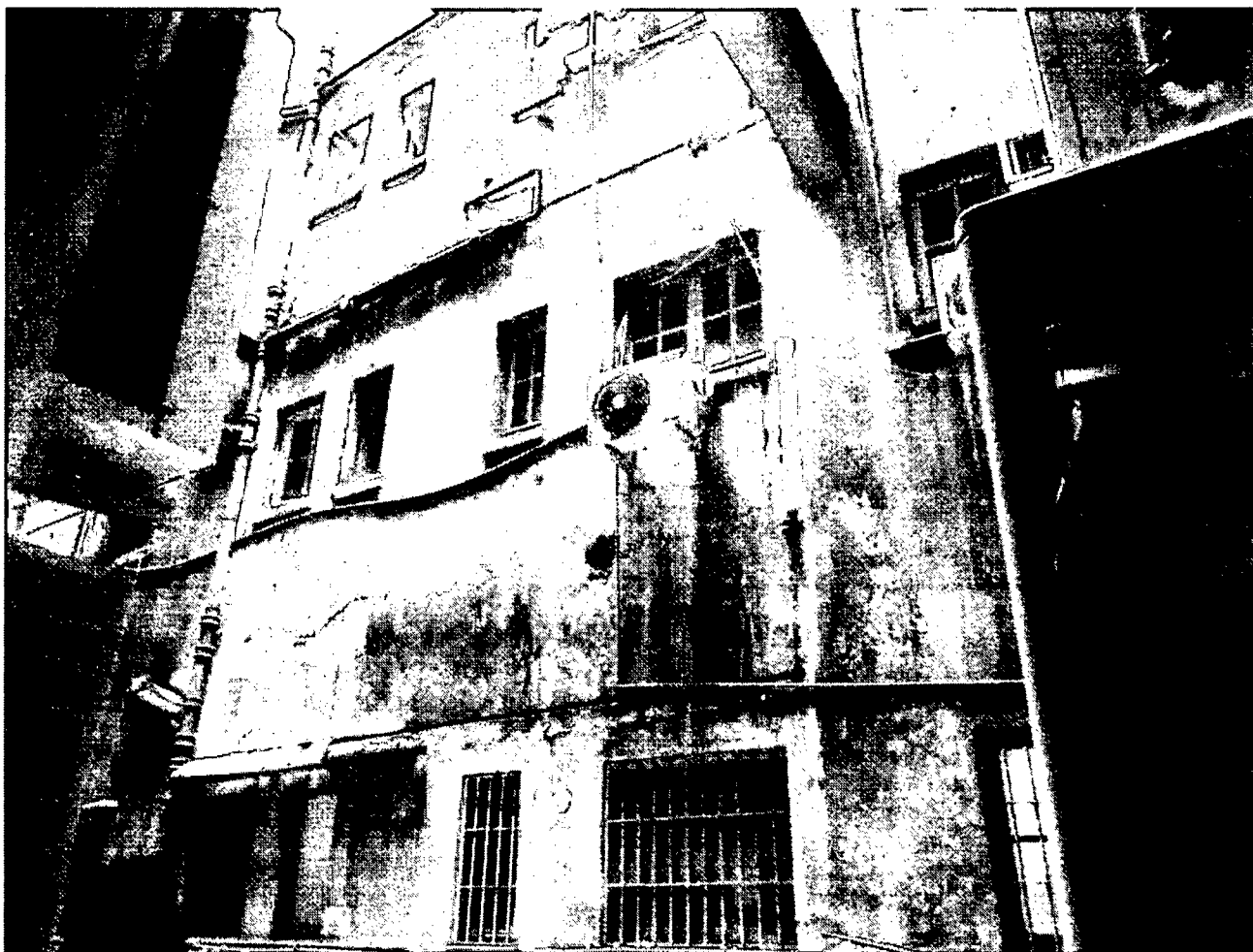
Foto 12: Muros interiores de patio de luz. Estos muros se apoyan sobre los pórticos que se muestran en Fotografías 7 y 8 de planos de corte.
