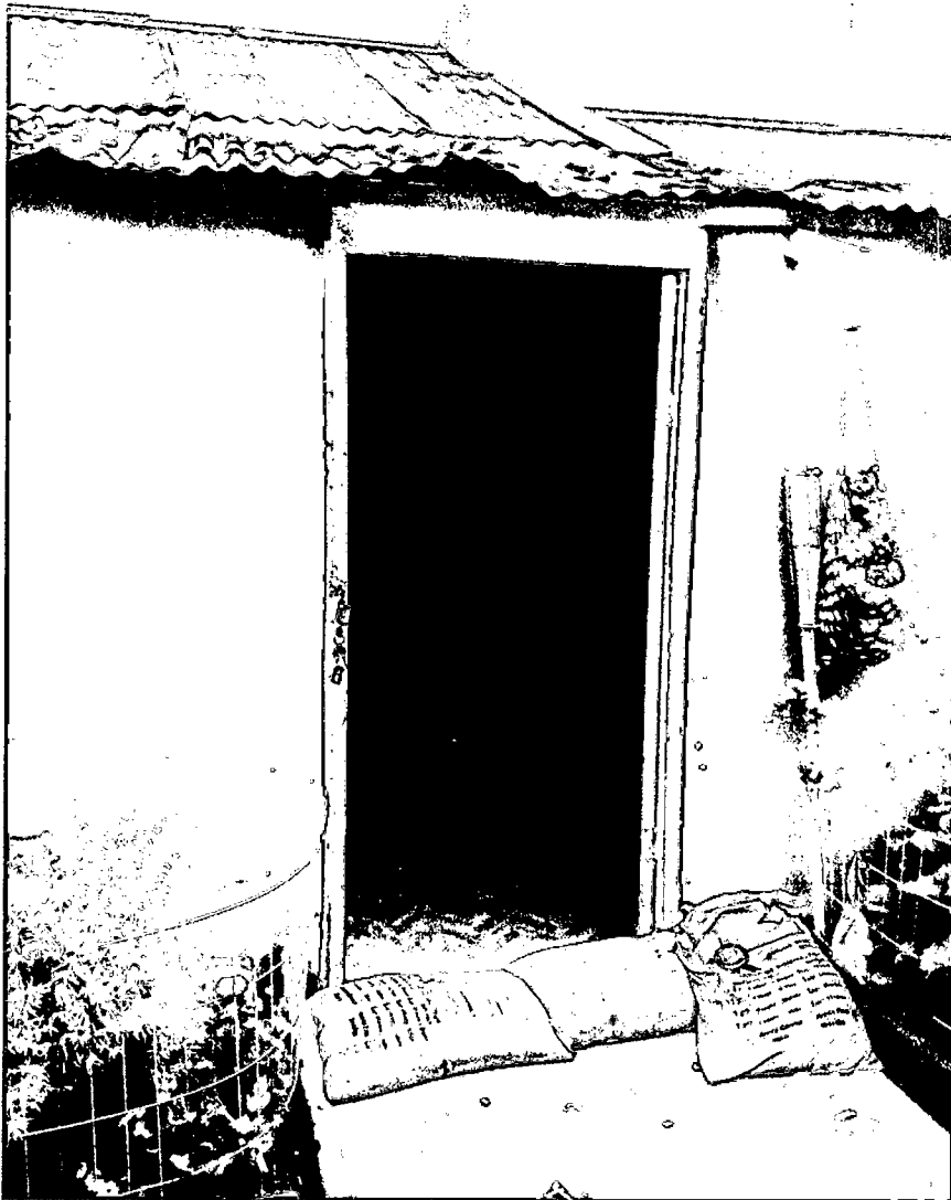
4. EDIFICACION INTERIOR - INGRESO
