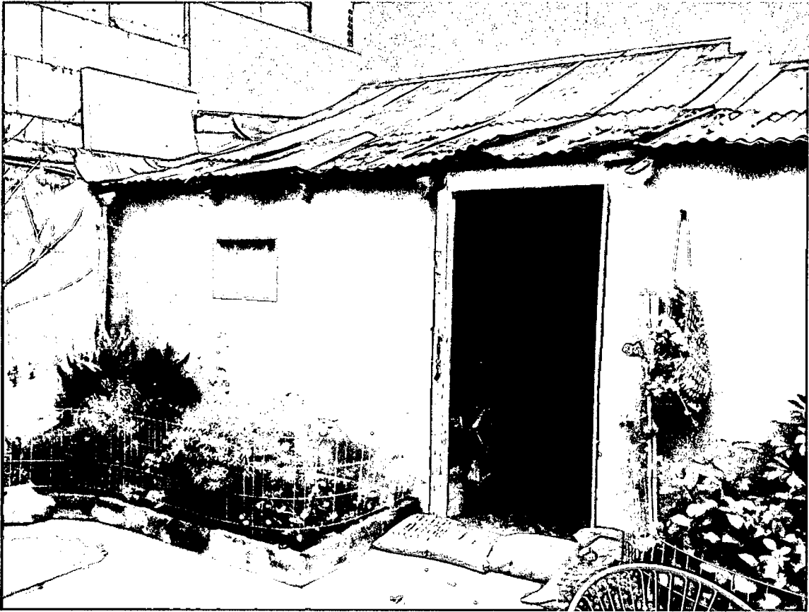
3. EDIFICACION INTERIOR - VISTA FRONTAL
