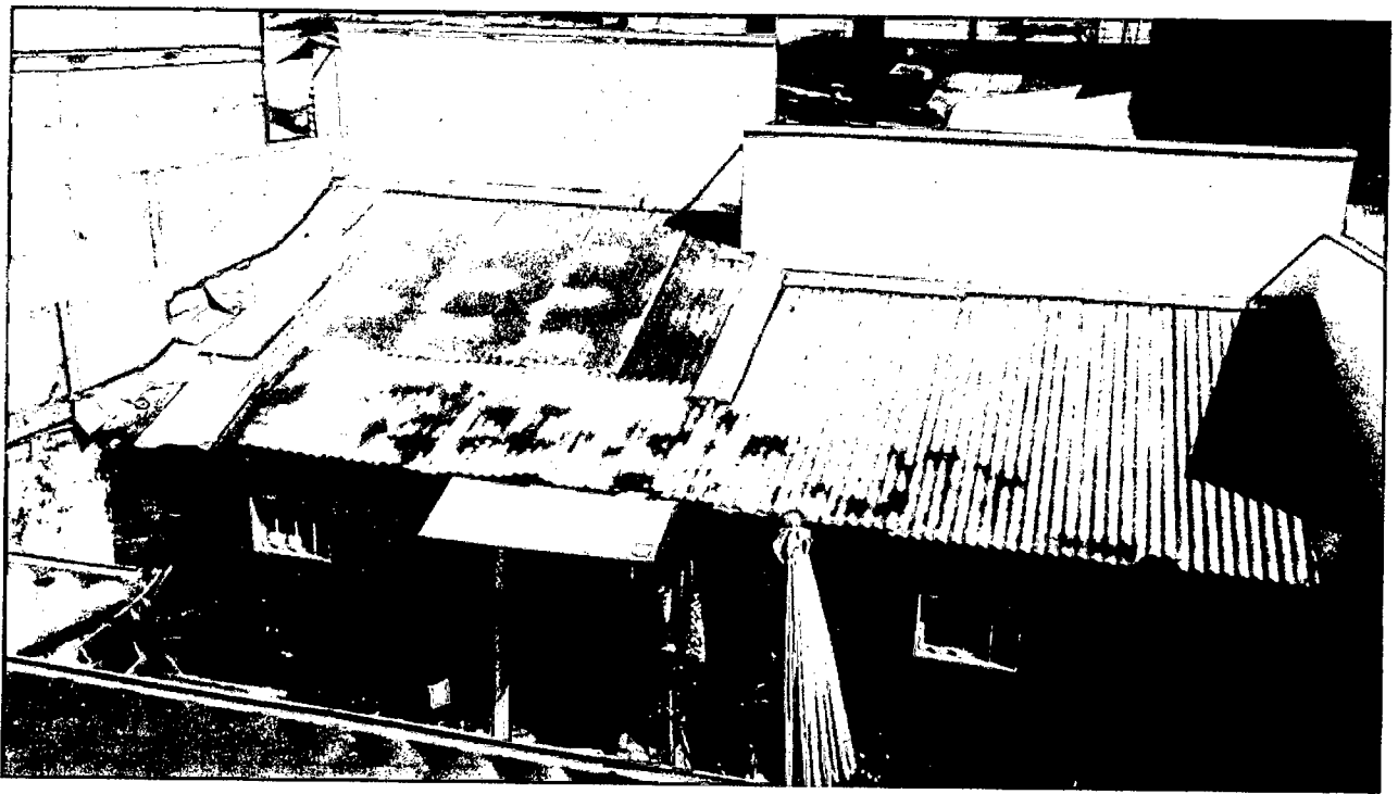
1. EDIFICACION INTERIOR - VISTA AEREA
