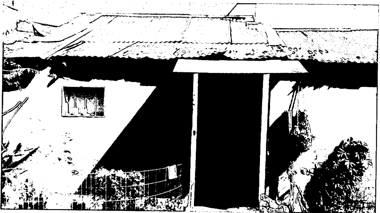
2. EDIFICACION INTERIOR - VISTA FRONTAL
