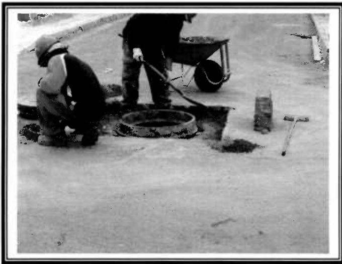
Trabajos de hormigonado de cámaras de inspección en a nivel de calzada, calle Juan Godoy de El Salado.
