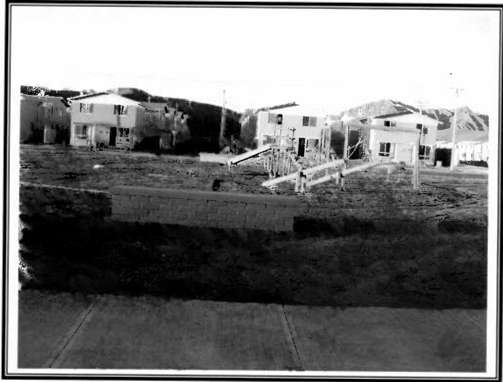
Viviendas, urbanización y equipamiento en proceso de término
