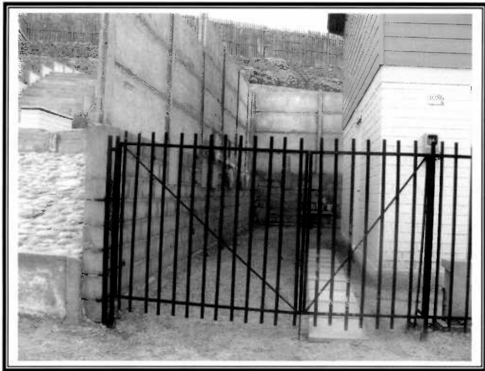
Tramos de muros de contención de 1,8 mts. de altura en albañilería de bloques
