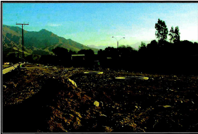
Fotografías N°s. 23 y 24 “Falta nivelación terreno”.
