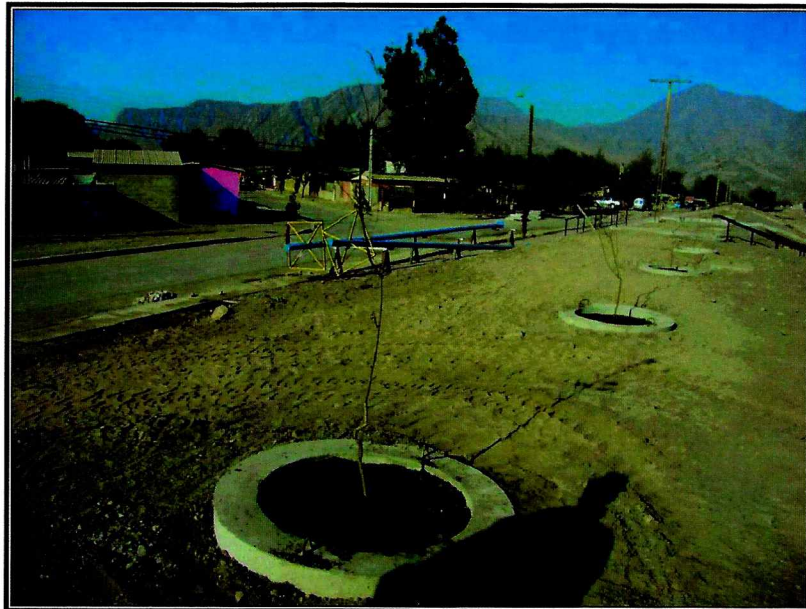
Fotografías N°s. 27 y 28 “Árboles instalados sin tutor”.
