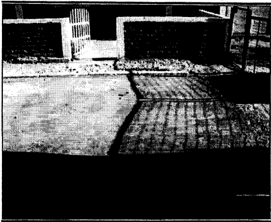
Foto N° 1 Fondo de pasaje sin soleras
