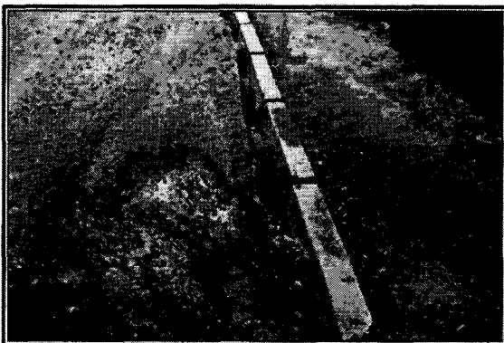
Foto N° 17 Pasaje Huamachuco, soleras instaladas sin remover el pavimento existente
