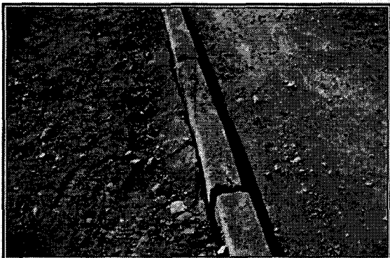
Foto N° 17 Pasaje Huamachuco, soleras instaladas sin remover el pavimento existente
