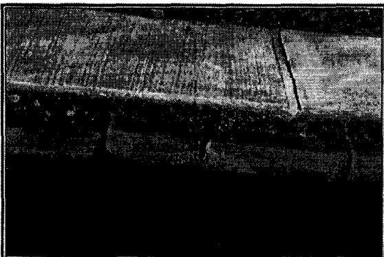
Foto N° 27 Guillermo Rojas, solera quebrada
