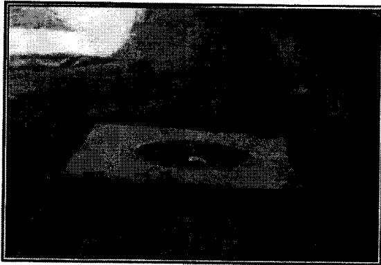
Foto N° 59 Guillermo Rojas, ejemplo de cámara sobre el nivel de la calzada terminada
