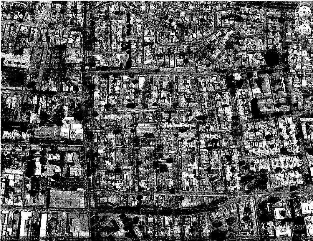
Imagen N°1: Vista aérea de la multicancha en población Cateador Almeyda.
