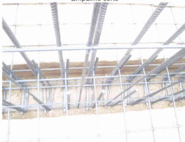
Foto N° 3 Falta emplastillado
